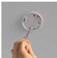
用螺丝钉将底座固定在天花板上
